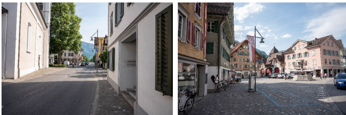
Abbildung 74: Extrem enge Querschnitte für Fussgängerinnen und Fussgänger an der Brünigstrasse (Hausecken im linken Bild, Laubendurchgang im rechten Bild)
